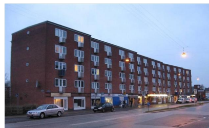
41 895 Søborghus Park 1-21, 2-24, Frederiksborgvej 221, 2860 Søborg
