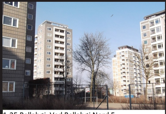
01-35 Bellahøj, Ved Bellahøj Nord 5
